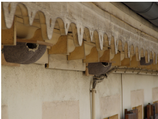
Les nids artificiels installés sous le toit de la façade du 138, rue du Général Leclerc
